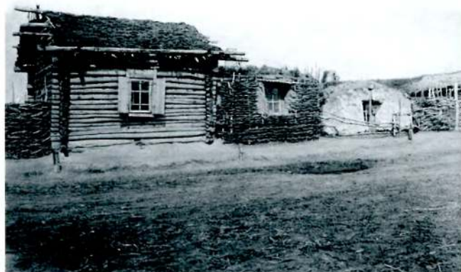
Рис. 186. Избы: бревенчатая; из двойного плетня; плетневая, обмазанная глиной. К а т а й ц ы
