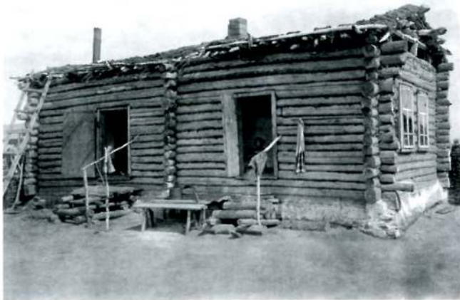
Рис. 189. Пятистенная изба с двумя входами. К а т а й ц ы
