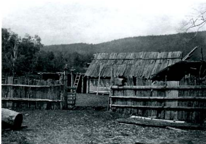
Рис. 115. Забор и крыша из полубины. Гирей-кипчаки
