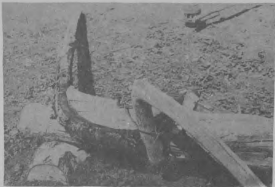
Процесс гнутья полоза (деталь). Фото автора (д. Аралбаево Зилаирского р-на БАССР; 1974 г.).
