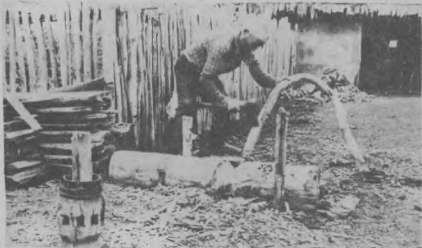
Стан для гнутья дуги (дуға станы). Фото автора (д. Ильмалы Зиянчуринского р-на БАССР; 1974 г.).
