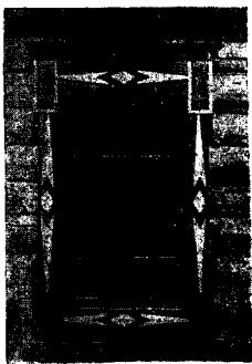
Рис. 9. Оконный наличник дома В. Усманова. Дер. Ново-Мещеро, Мечетлинский район БАССР.
