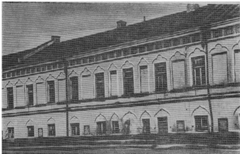
Рис. 2. Дворовой фасад основного корпуса.
