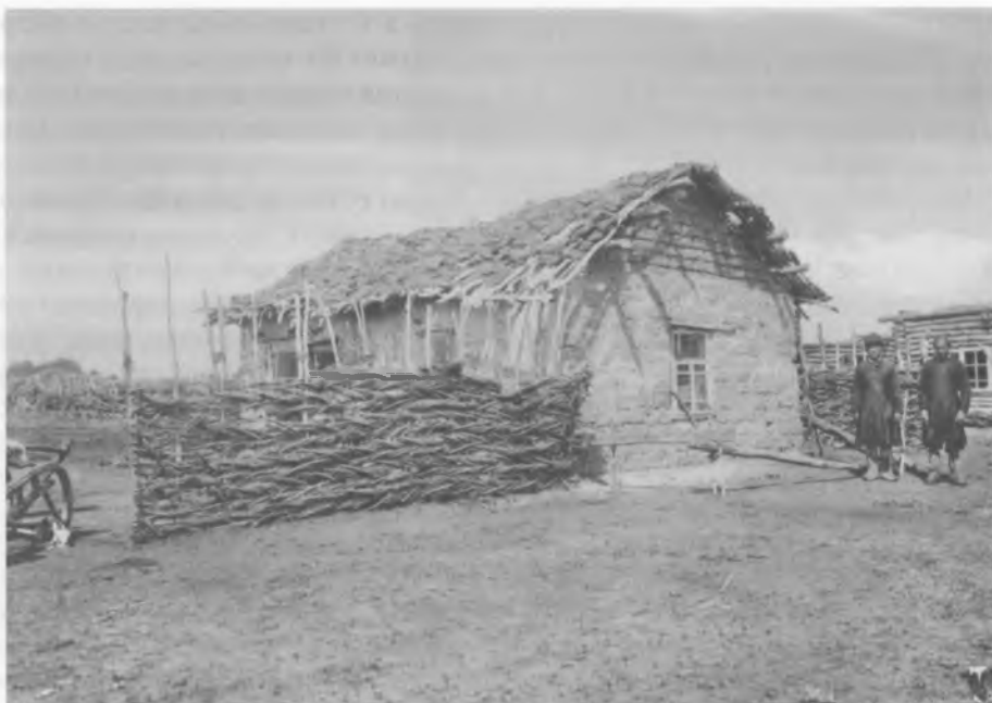
Изба из воздушного (сушеного на солнце) кирпича Оренбургская губ., Челябинский у. Фото С.И. Руденко, 1912 г. © РЭМ. № 3935-202
