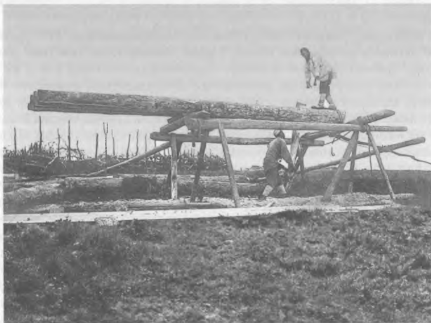
Распиловка бревен. Начало XX в.
