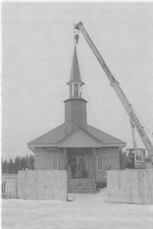
Строительство новой мечети
