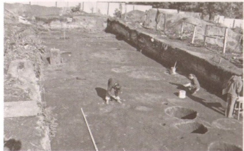
Рис. 73. Городище Уфа-II. Линия 9-10 на уровне горизонта 7 в ходе выявления столбовых ямок
